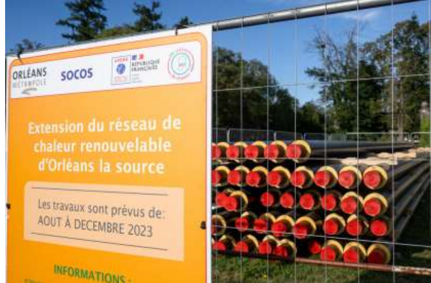
Déploiement du réseau de chaleur Echangeur thermique Octobre 2023, photos par Didier DEPOORTER
