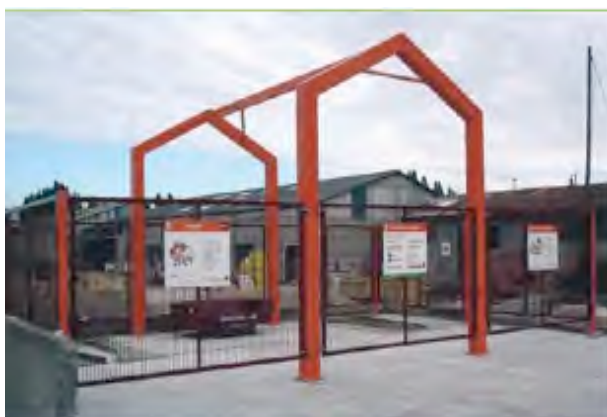
Une déchèterie POINT P
