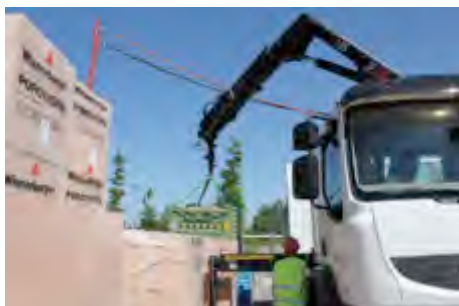
Chantier propre de construction
