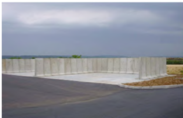
Aire de stockage en alvéoles
