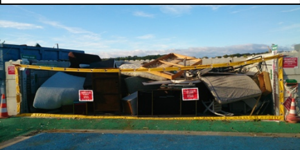
Pose de filet de protection Copyright : Syndicat Centre Hérault
